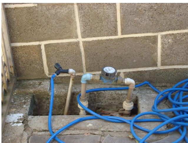
**Figura 20** – Situação de cavalete e hidrômetro instalado.
